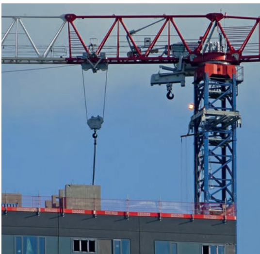
Construcción de la Torre Kista. Estocolmo, Suecia.
